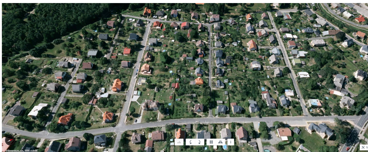
Obrázek B-3: Zástavba rodinných domů (orientace je shodná jako celková situace projektu skutečného provedení stavby).
